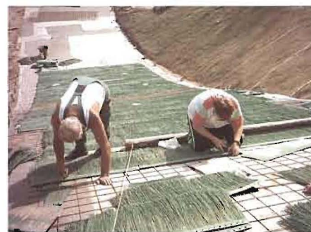
Alles noch echte Handarbeit: Auf die Aufsprunghänge der drei neuen Schanzen mussten mehrere tausend Kunststoffmatten geknüpft werden.
