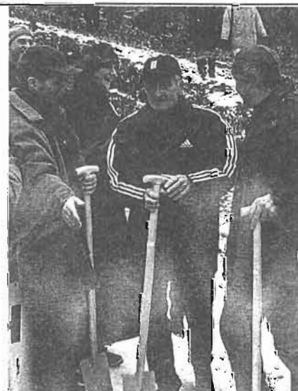
Olympiasieger von 1960 Helmut Recknagel setzt den ersten Spatenstich für die neue K 40-Skisprungschanze in Bad Freienwalde
